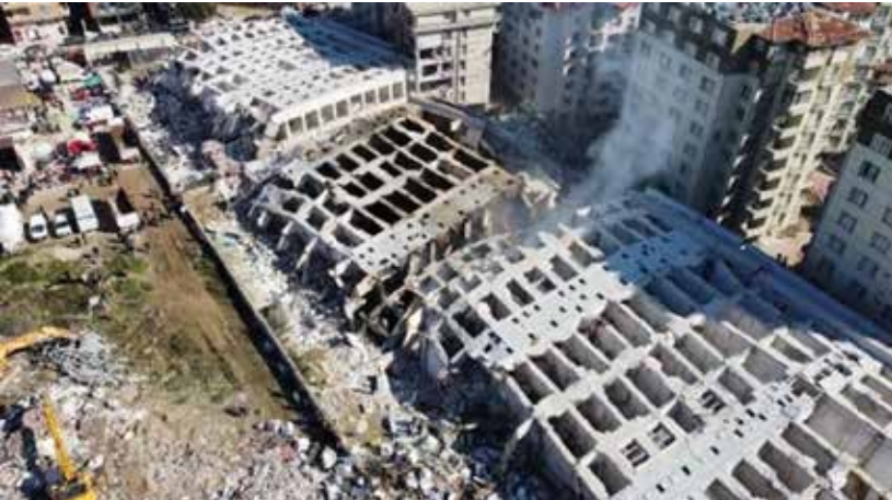
Şekil 7. Antakya kent merkezinde düz ve düze yakın alanlarda yapılan çok katlı binaların temelden devrilmesi (Anonim, basın, 2023)
