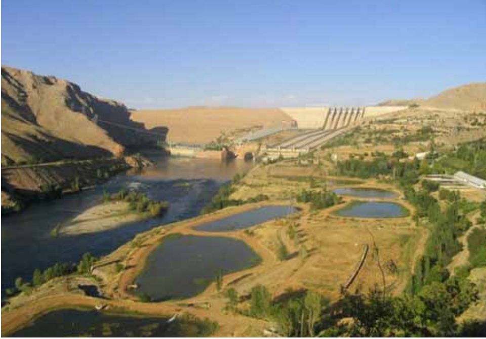
Şekil 3. Keban Baraj Gölü
