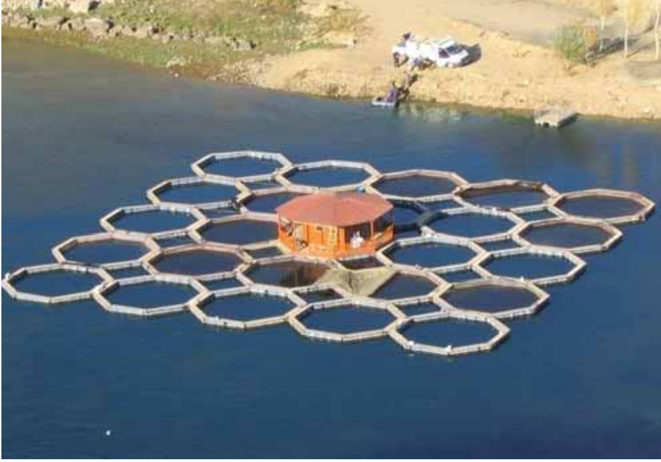
Şekil 5. Çokgen Şekli (Sekizgen) Kafesler
