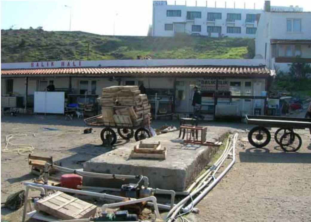
Şekil 4. Bozcaada Balık Hali Genel Görünüm (3)
