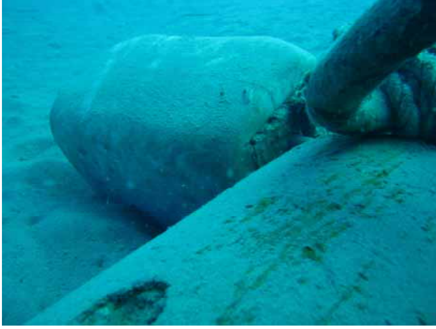
Şekil 4. Yüzer resifin sabitletmesinde kullanılan beton tonozlar
