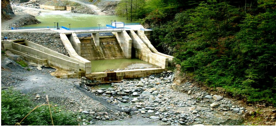
Şekil 1: Doğu Karadeniz de bir HES regülatörü ve balık geçidi( foto: Orhan AK)
