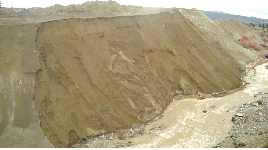
Şekil 20. Niyazlar Köyü Aşağı Açık Krom Maden İşletmesi Atıklarının Değirmen Dereye Bırakılması, Celal Güzelyürek, 2016
